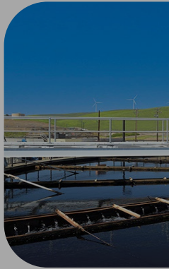
DVWTP HVA Impr
